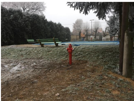
Obr. 5: Hydrant pro napouštění obecní požární nádrže
